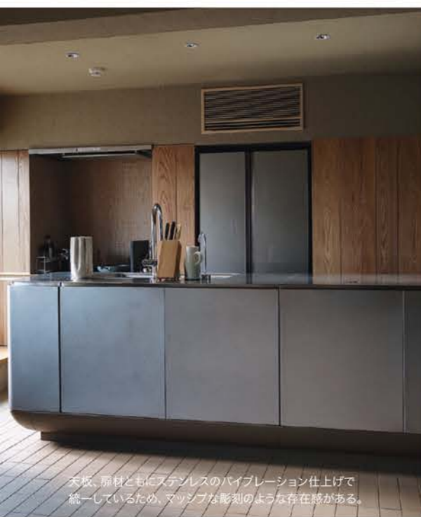
職人が最も苦労したという四隅のカーブ。カウンター下の収納は扉がカーブしたまま開閉する。
